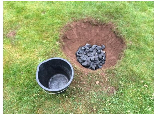
Schritt 4: Zwei Eimer voll Basaltsteine einfüllen
